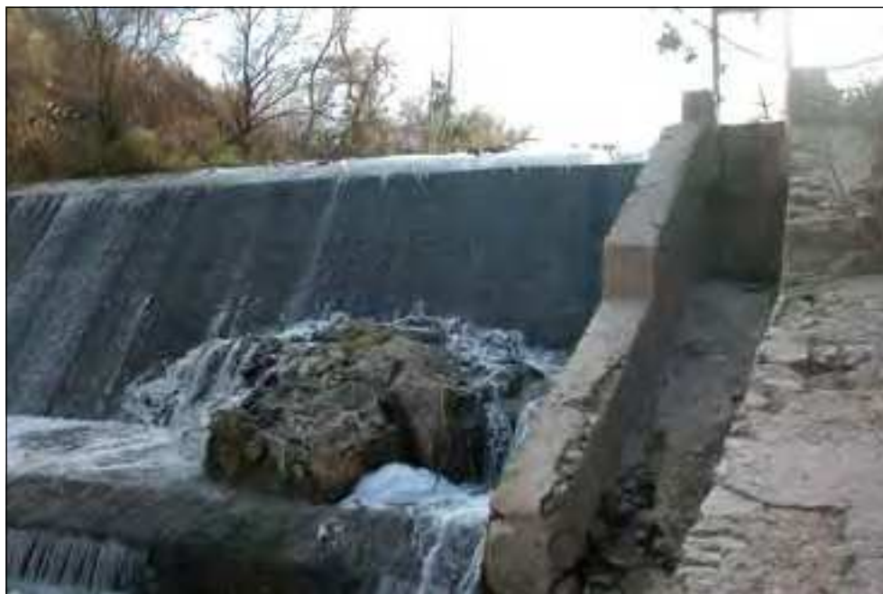
Fig. 2. Compuerta de hierro y canal aliviadero en la azuda del molino del Cerrajón, situado sobre el río Salado, en el término municipal de Luque.
