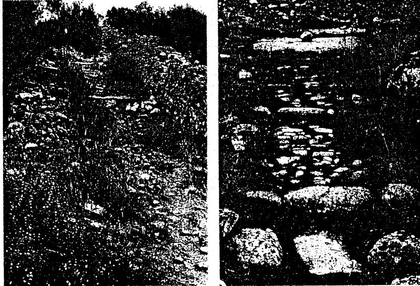
Via Corduba-Castulo por Iliturgis en las inmediaciones de Porcuna (Jaén). Puede apreciarse un tramo de pendiente con las rampas escalonadas (fig. 5) y el sistema empleado para que los carros salvaran los escalones (fig. 6).
