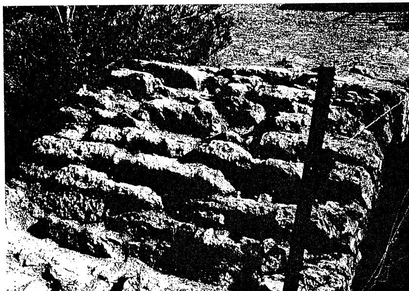
Puente sobre el arroyo de Linares: detalle del dovellaje.
