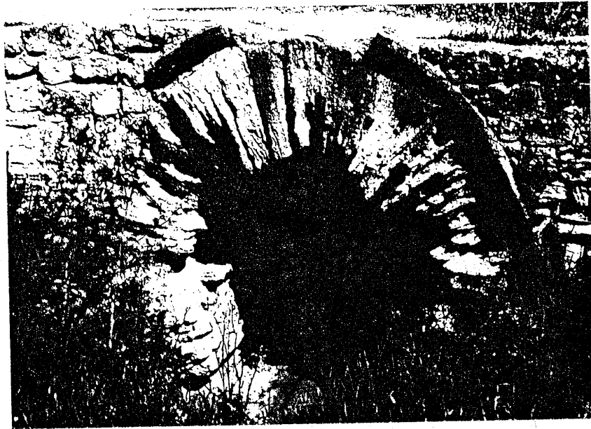
Alcantarilla musulmana conservada sobre la Vía Corduba-Malaca, en las inmediaciones de Montilla
