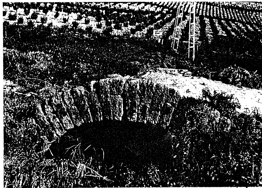
Puente sobre el arroyo de Fontalba.
