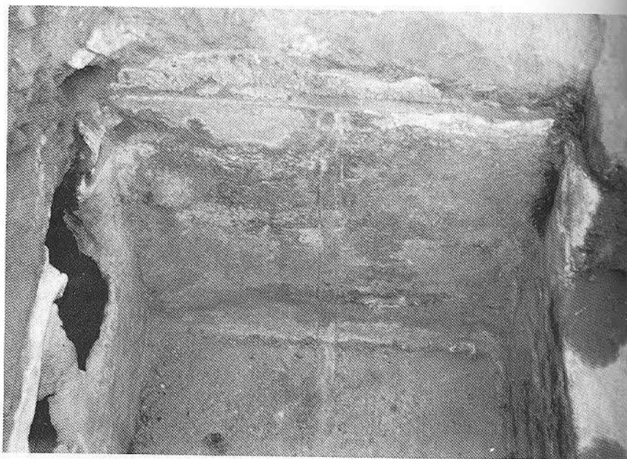
Lám. 4. Detalle del revestimiento de plomo de la cabeza de sifón/castellum divisorio.
