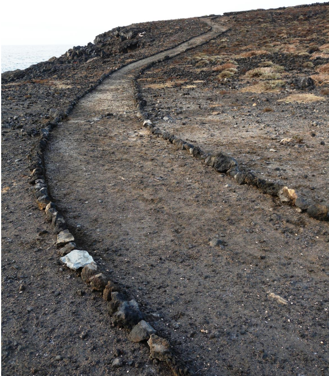
Foto 5.- La denominada “rambla de los Caballos”, en la costa de San Juan de la Rambla (norte de Tenerife), uno de los pocos tramos que aún se conservan del Camino Real de la costa.
