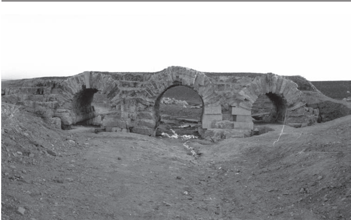
Lám. 11: Alzado norte del puente una vez restituidas las piezas originales.
