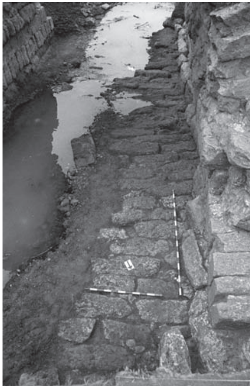
Lám. 2: Zampeado del puente en la zona occidental de la pila.
