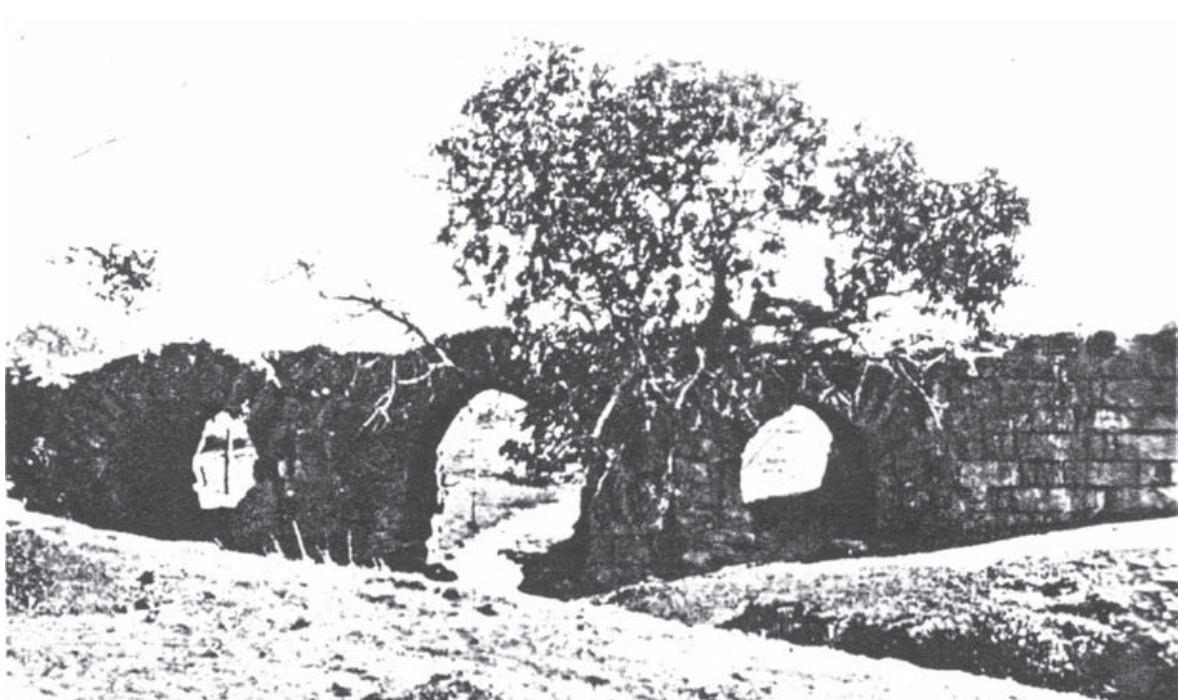
Lám. 4: Estado de conservación de la cara norte del puente en 1924 (JIMÉNEZ et al., 1924: 15, Lám. VI).
