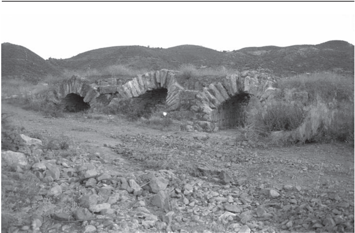
Lám. 1: Puente de los Nogales. Alzado sur. Estado del puente previo a la intervención arqueológica.
