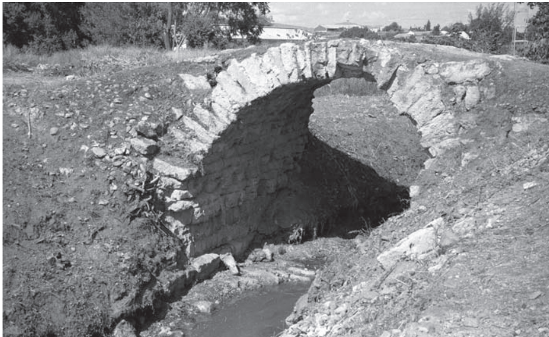
Lám. 1: Alzados sur del puente antes de la intervención arqueológica.
