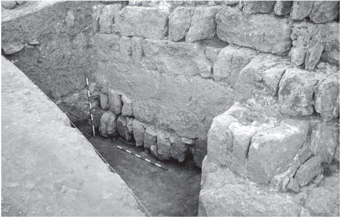
Lám. 5: Corte 8. Cara norte del puente, detalle de la cimentación del estribo oriental.
