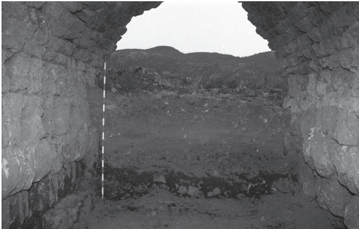
Lám. 3: Perfil del ojo central del puente tras la retirada de los rellenos de colmatación depositados a partir de 1924.
