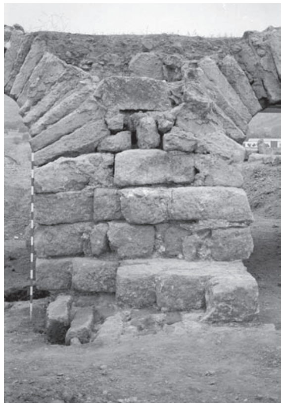
Lám. 8: Alzado sur del puente, detalle de la pila oriental.
