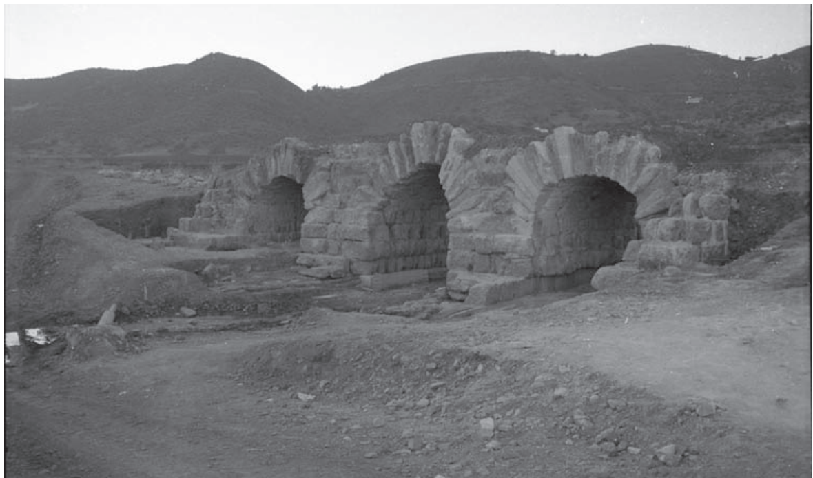
Lám. 2: Puente de los Nogales. Alzado sur. Estado del puente tras la intervención arqueológica.
