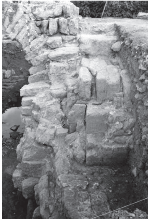
Lám. 3: Contrafuerte en el alzado sureste del puente.
