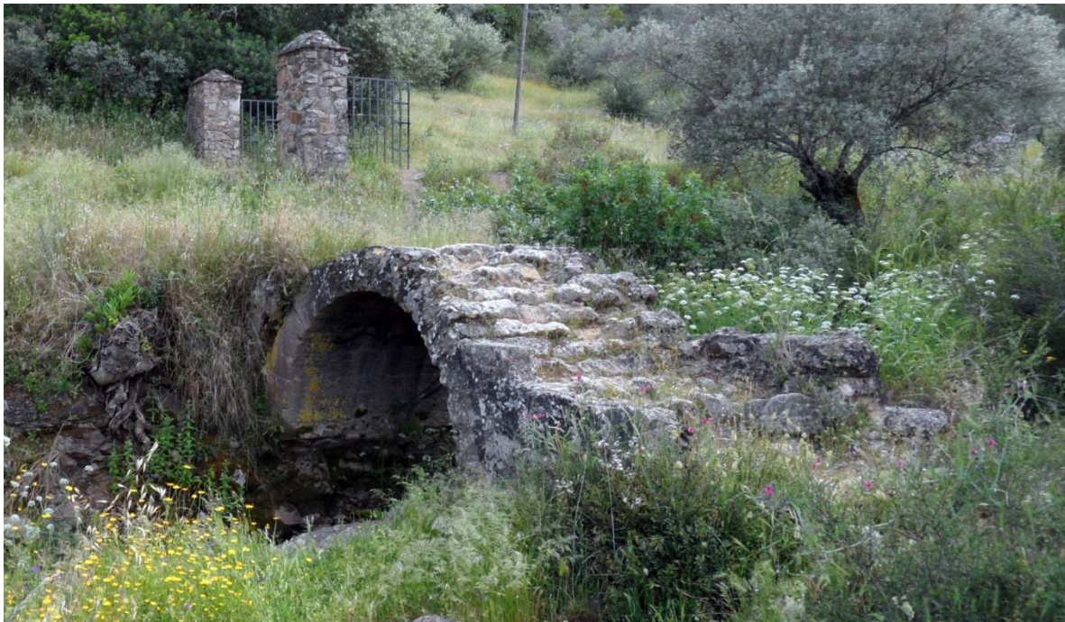
Fig. 78 Vista desde el estribo norte.
