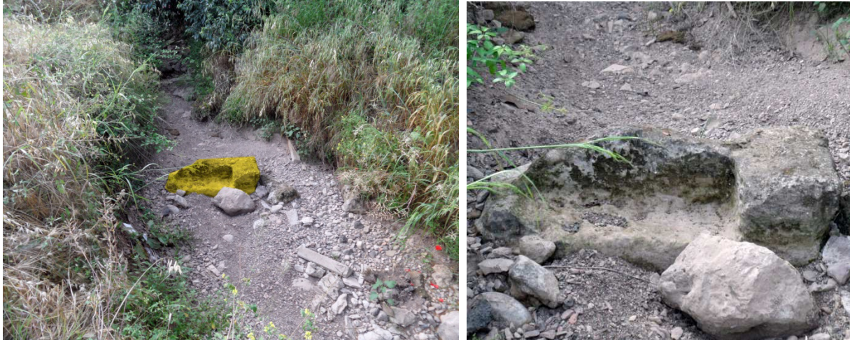
Fig. 67 y 68 Pieza situada aguas abajo (posible mechinal o peldañeado).
