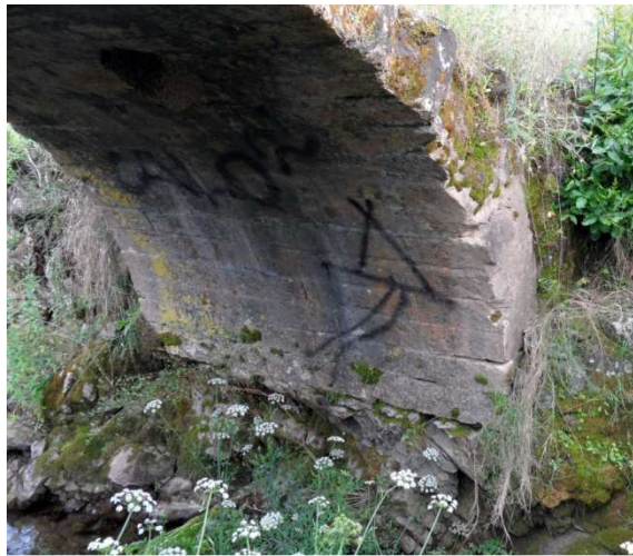
Fig. 74 Grafitis en intradós de la bóveda. Fig. 75 Desgaste de las dovelas superiores.
