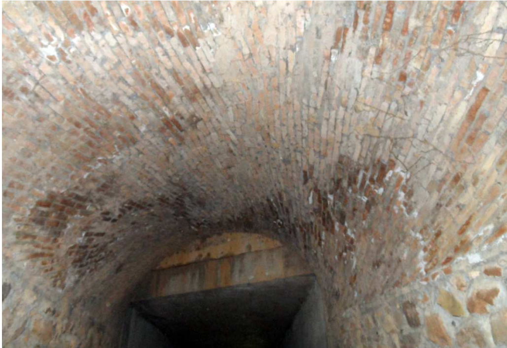
Fig. 109 Aparejo de hiladas oblicuas de ladrillo en bóveda.
