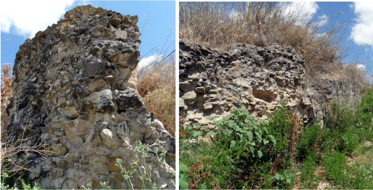
Fig. 170 y 171 Bloques de opus caementicium situados: aguas abajo y aguas arriba.
