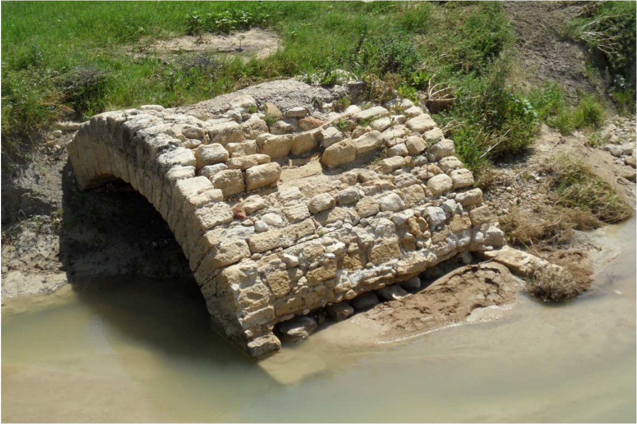
Fig. 159 Vista desde la margen derecha.
