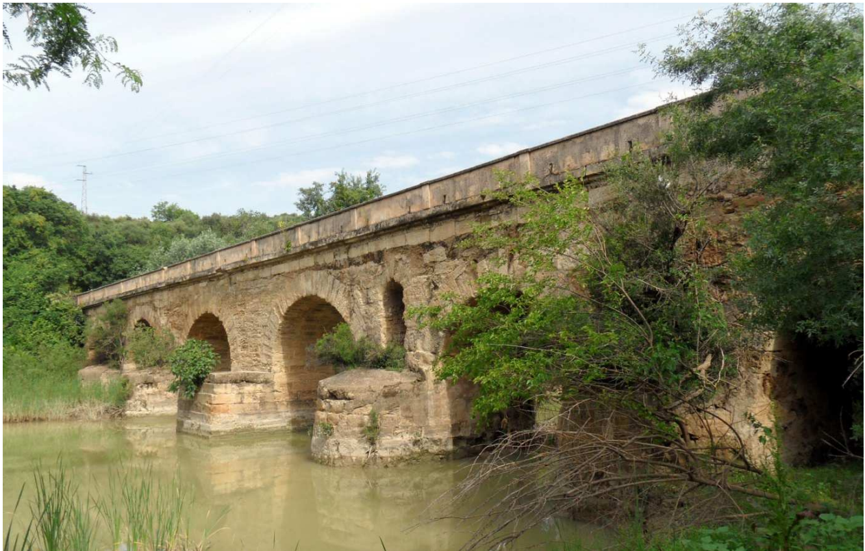
Fig. 126 Vista general aguas abajo.
