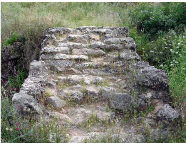
Fig. 72 Trasdós de la bóveda desde estribo norte.
