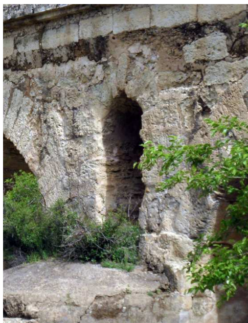
Fig. 115 Aliviadero entre vanos 4-5.
