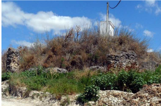
Fig. 167 Bloques de hormigón del estribo.
