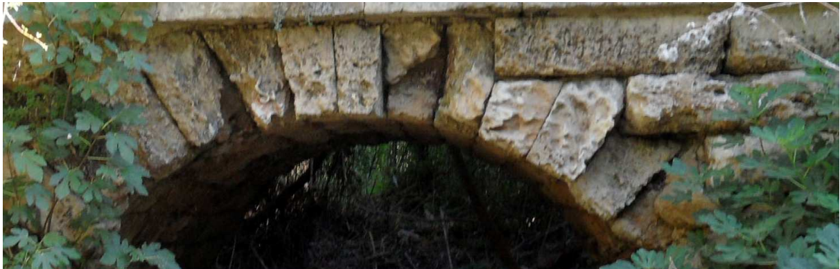
Fig. 42 Alzado aguas abajo de bóveda 2.
