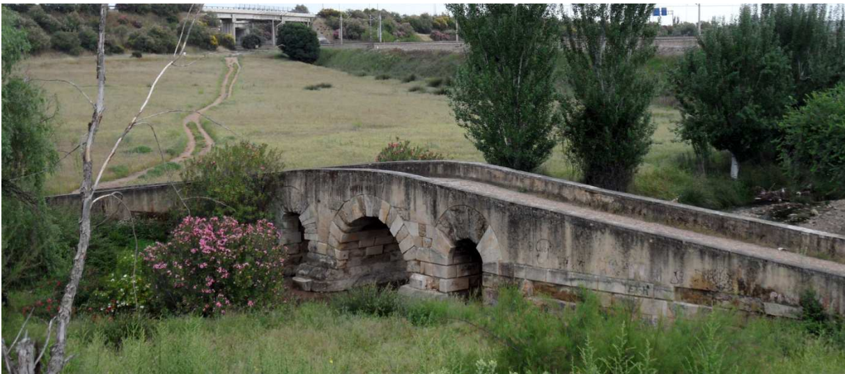
Fig. 34 Vista general aguas arriba del puente.
