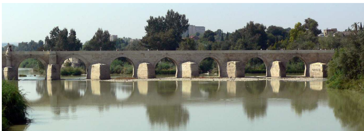
Fig. 15 Vista desde aguas arriba.
