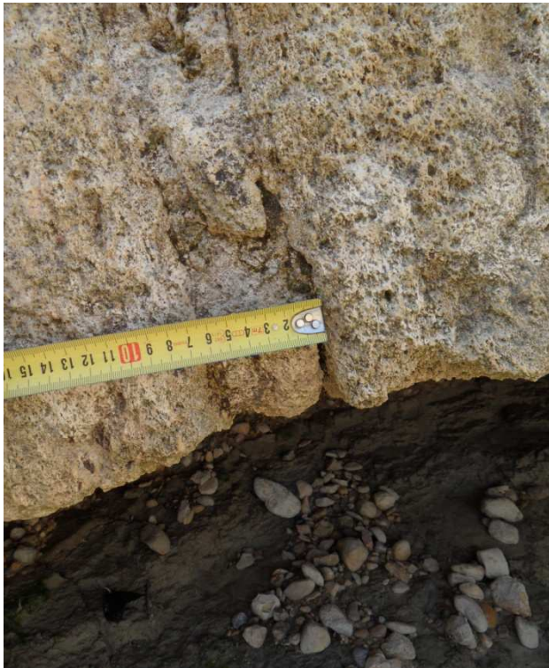
Fig. 157 Juntas de hasta 6 cm en el intradós
