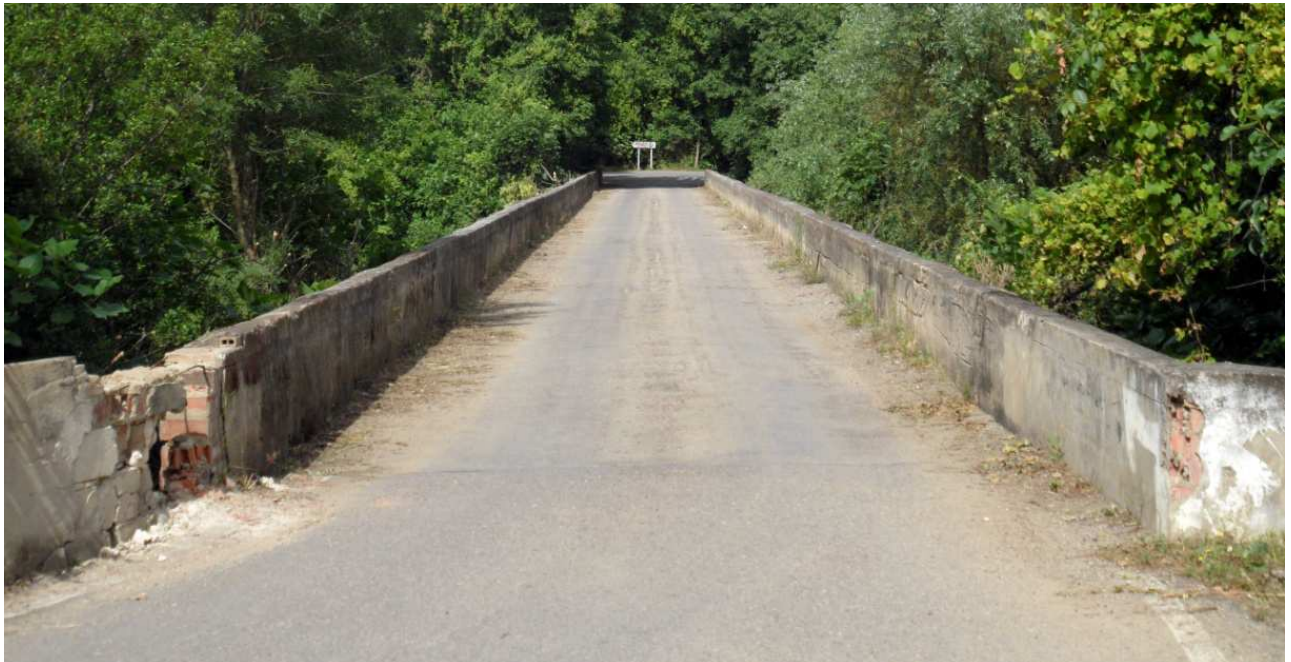
Fig. 120 Tablero desde la margen izquierda.
