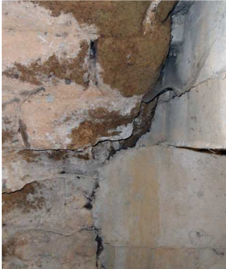
Fig. 102 Encuentro de bóveda con marco de hormigón.
