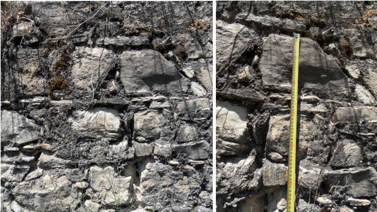
Fig. 172 y 173 Mampostería aguas arriba del estribo.
