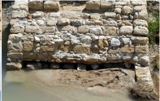
Fig. 154 Ripiado entre dovelas.
