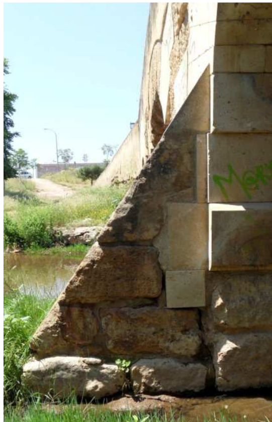
Fig. 28 Contrafuerte aguas abajo.
