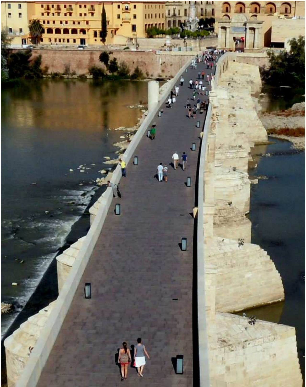
Fig. 20 Vista general del puente desde la cubierta de la Torre de la Calahorra.
