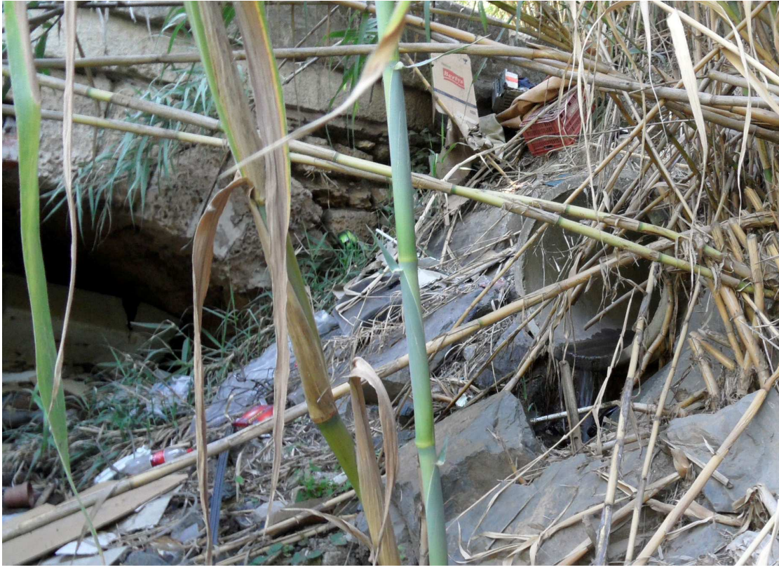
Fig. 49 Colector de evacuación y escollera que ciega parcialmente la bóveda 1.
