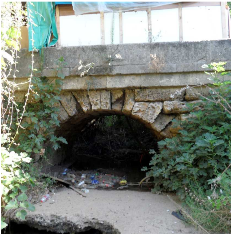
Fig. 50 Solera de hormigón con socavación aguas abajo. Fig. 51 Chabolas sobre el tablero del puente.
