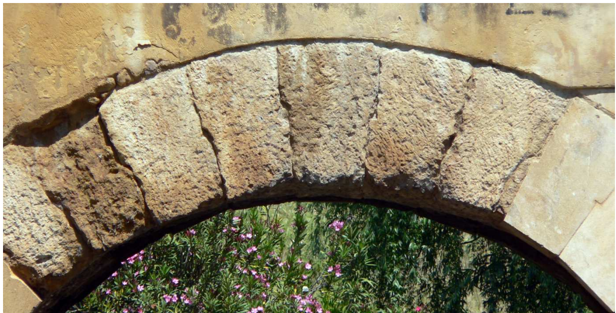
Fig. 26 Engatillado de las dovelas del arco central.
