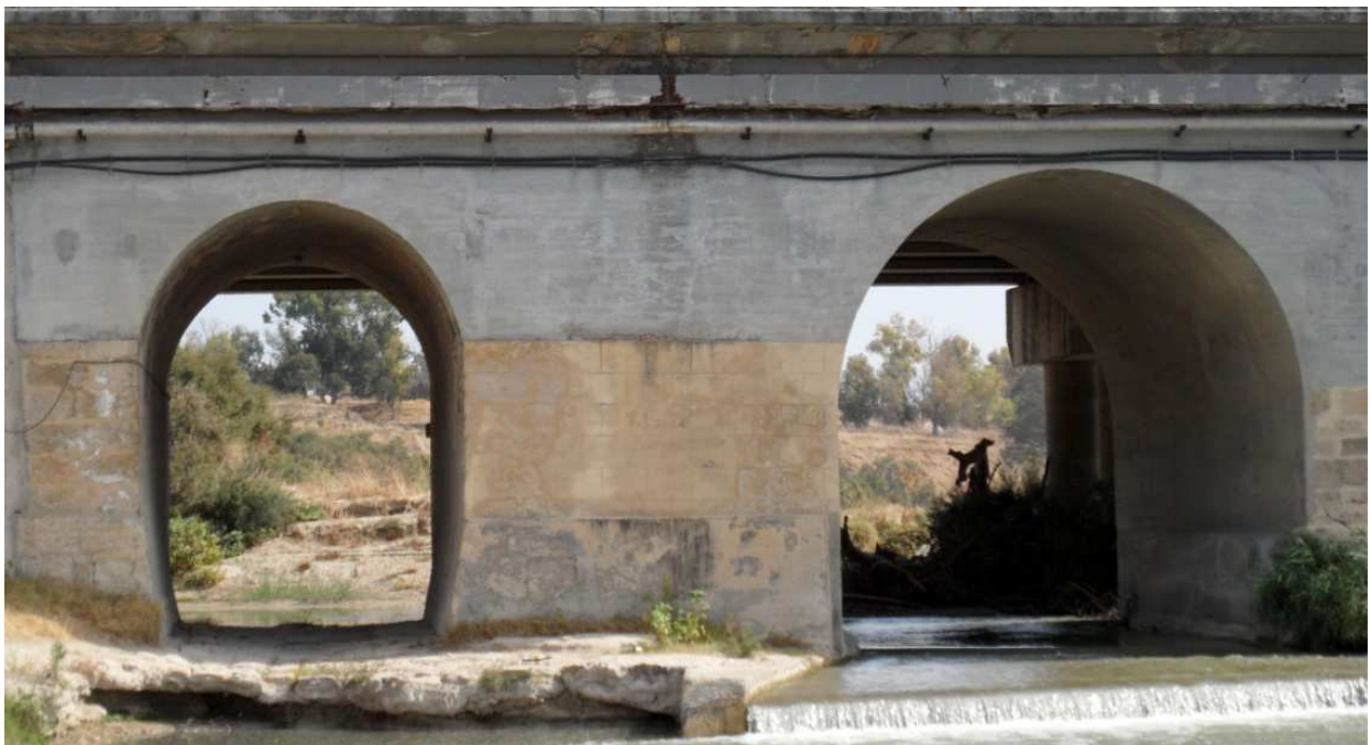
Fig. 139 Alzado aguas abajo de las bóvedas 6 y 7.
