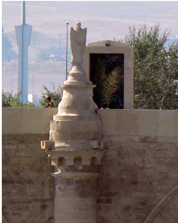
Fig. 18 y 19 Hornacina reconstruida en el espolón de la pila situada entre los arcos 9 y 10.
