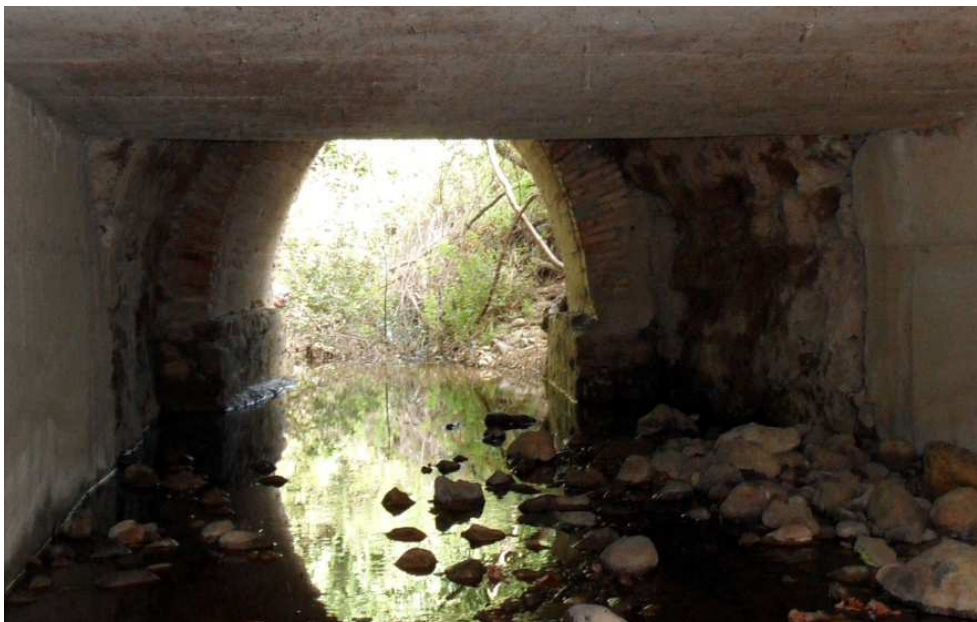
Fig. 101 Obra original y sus dos ampliaciones.
