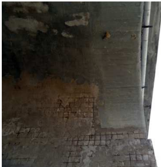
Fig. 131, 132 y 133 Bóveda 7: Ampliación aguas arriba, tramo central revestido, y ampliación aguas abajo.
