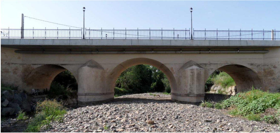
Fig. 83 Vista general del puente desde aguas arriba en la actualidad.
