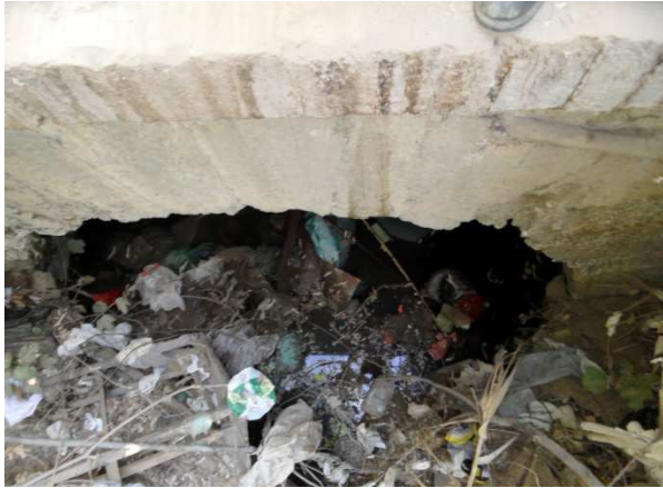
Fig. 52 Plataforma sobre bóveda 5 sin pretil.
