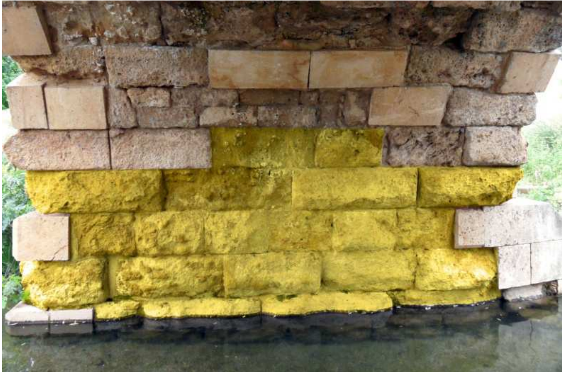
Fig. 31 y 32 Estribo derecho aguas arriba y pila derecha en bóveda central. Resaltados sillares originales.
