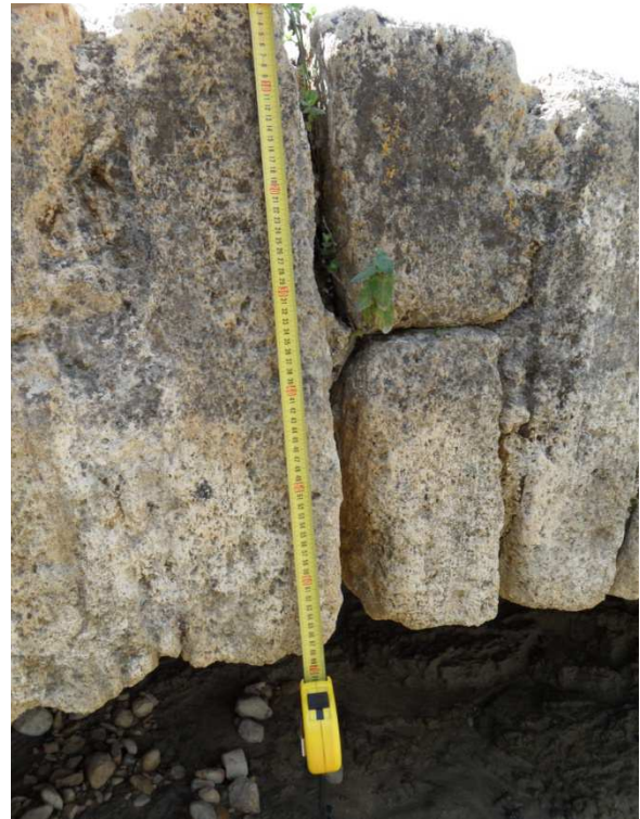
Fig. 158 Espesor de rosca de 70 cm.
