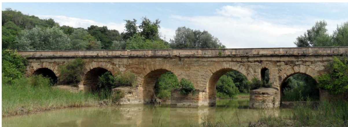
Fig. 114 Vista general desde aguas abajo.
