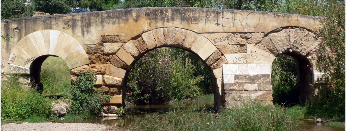
Fig. 33 Alzado aguas abajo del tramo central.
